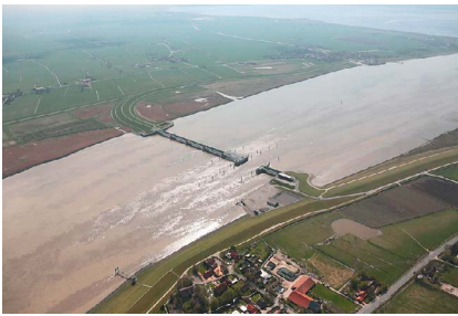
Emssperrwerk bei Gandersum
