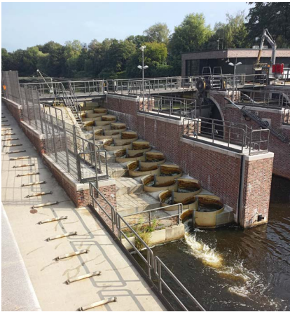
Fischtreppe an der Fuhlsbütteler Schleuse (Alster)
